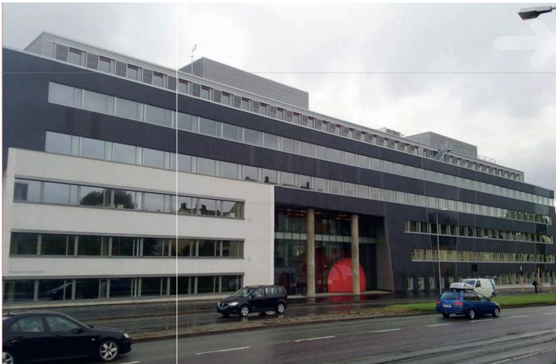
ENKLE MIDLER: Fra utsiden ser KLP-bygget ut som ethvert kontorbygg. Så er det også de enkle midlene som har gjort det til landets mest energieffektive kontorbygg.
