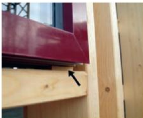
KLOSS TIL BESVÆR: Trykktester viste at klossene under vinduene lå for langt ut. Det førte til at fugen ble bøyd ut eller brutt, og det oppstod luftlekkasje. Klossene ble flyttet på alle 560 vinduer, og dermed ble det tett.
